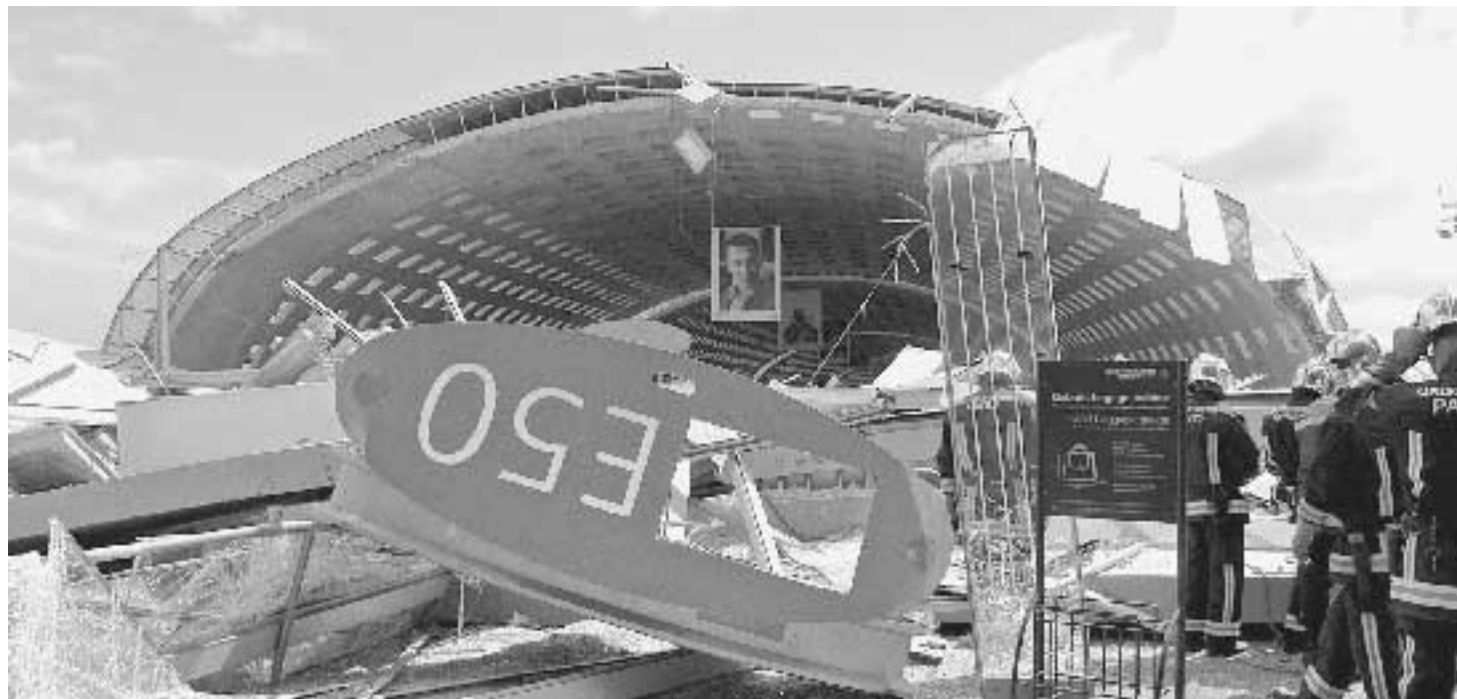
Il tunnel crollato domenica all'aeroporto parigino Charles de Gaulle
