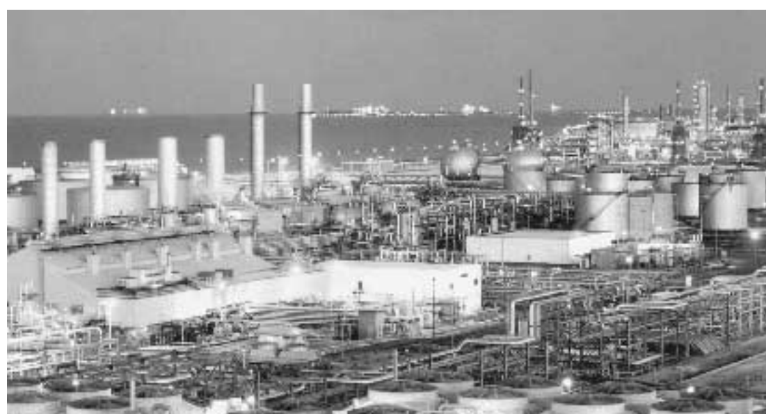
Raffinerie di petrolio a Dhahran in Arabia Saudita
