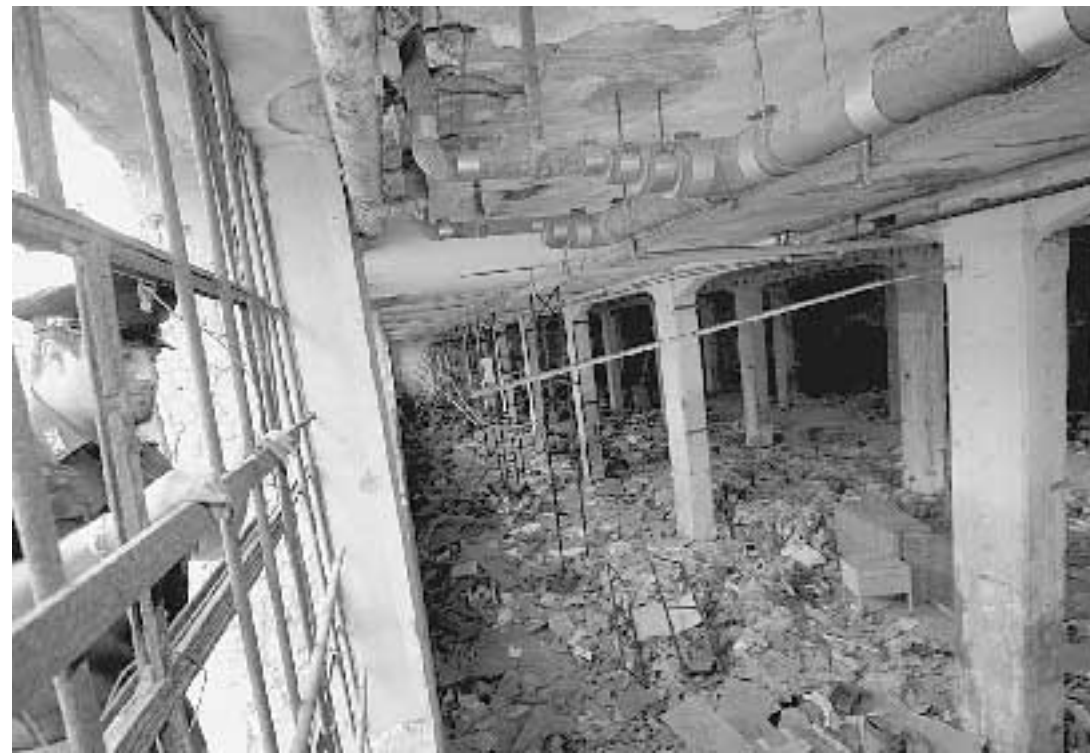
Il cantiere posto sotto sequestro dove lavorava Francesco Iacomino, a Ercolano
