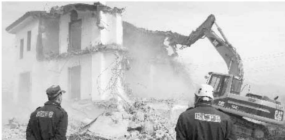
Una villetta abusiva in pieno parco del Vesuvio, demolita dalle ruspe
