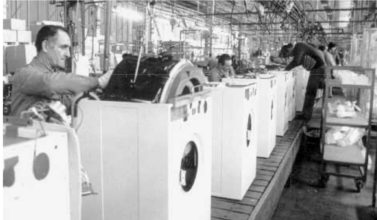
L'interno di uno stabilimento della Zanussi
