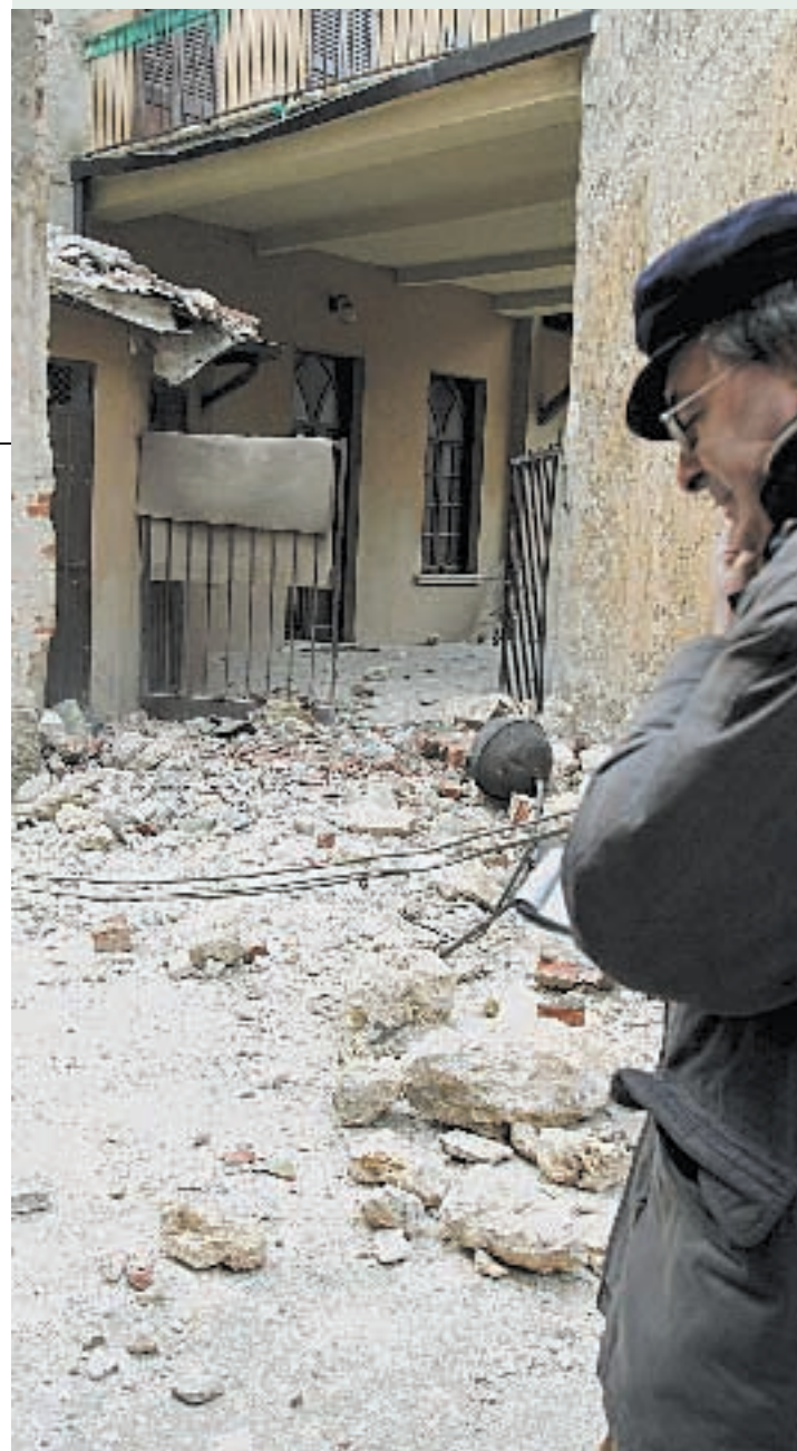
I danni del terremoto a Salò
