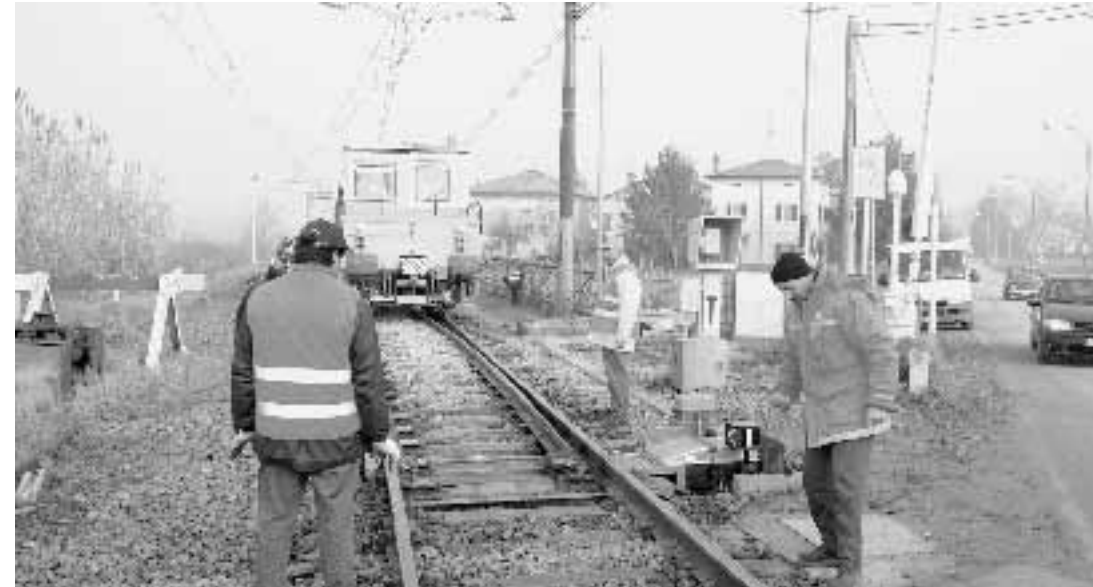
Lavori sulla linea ferroviaria Bologna-Verona a Crevalcore
