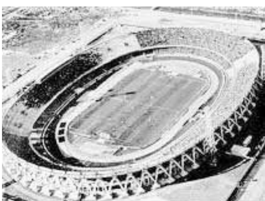
In alto a sinistra Franco Carraro e Silvio Berlusconi. In alto lo stadio Olimpico di Roma. A sinistra il «vecchio» S. Elia di Cagliari prima dei lavori di ristrutturazione che hanno eliminato la pista di atletica
