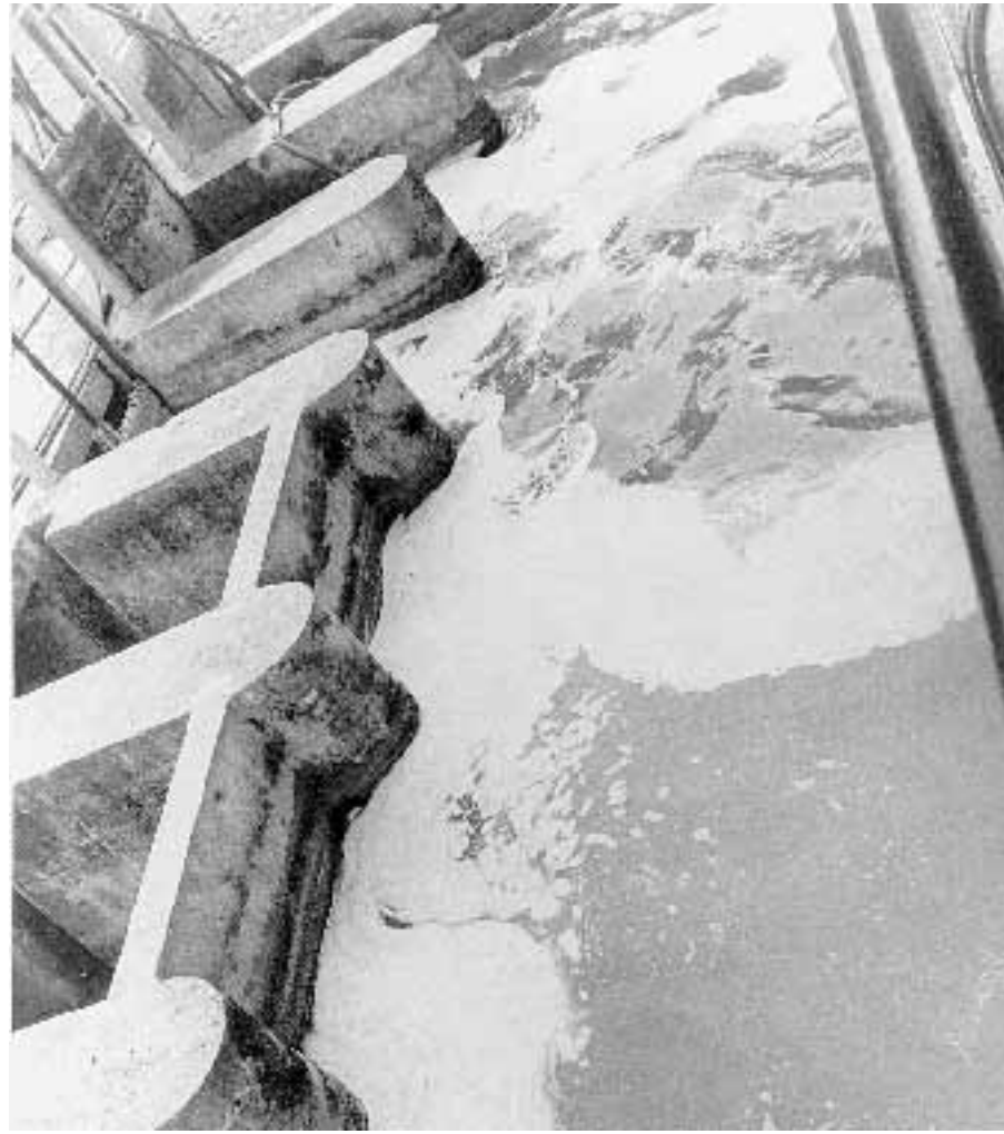
Un depuratore sulle coste laziali
