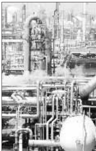
Gli impianti di Marghera
