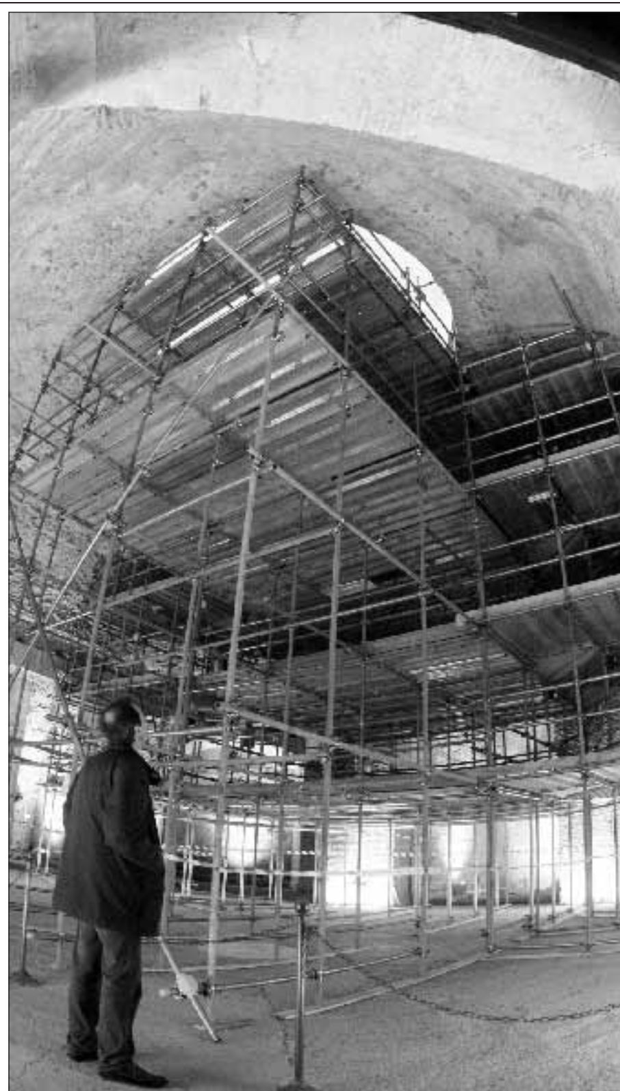
Un'impalcatura di sostegno in una sala della Domus Aurea neroniana. Foto di Di Meo/Ansa
