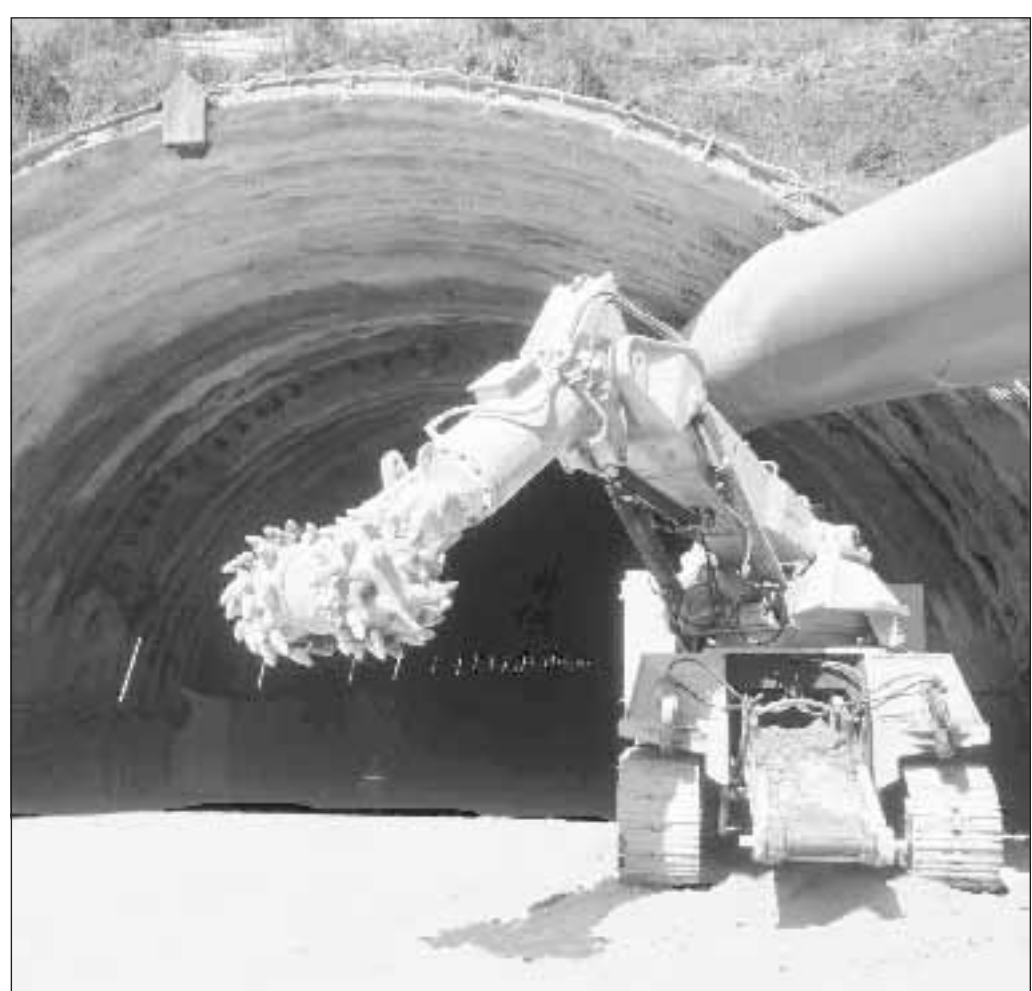
Un cantiere sull'autostrada Salerno-Reggio Calabria
