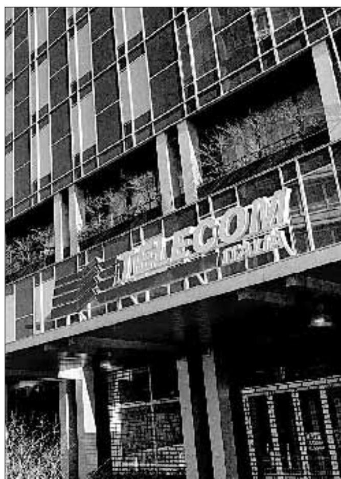
La sede della Telecom Italia a Milano. Foto Ferraro/Ansa
