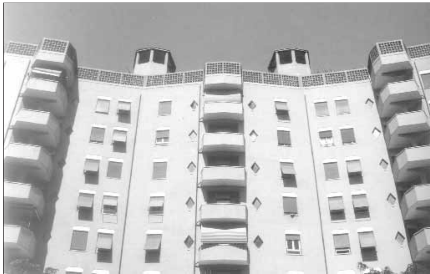
Casa detta dei «44 appartamenti» a Terni di Ridolfi e Frankl
