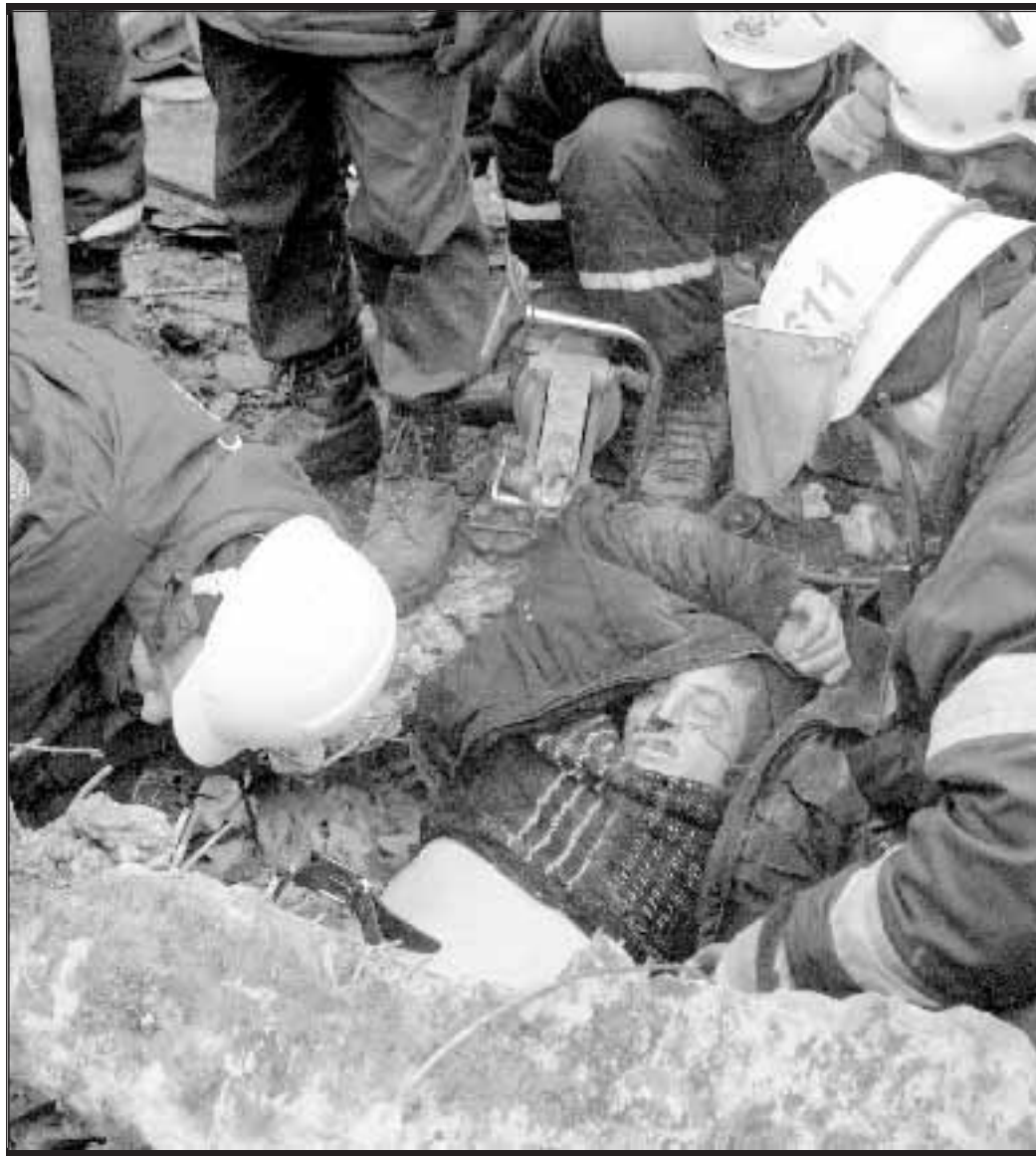
Mosca, crolla tetto per neve: 50 morti
