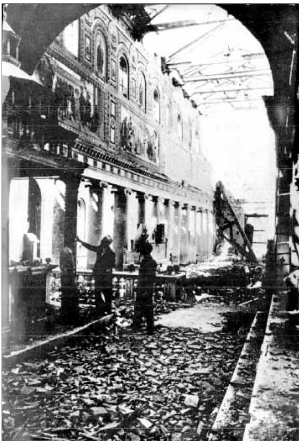
L'interno della Basilica di San Lorenzo dopo il bombardamento del '44
