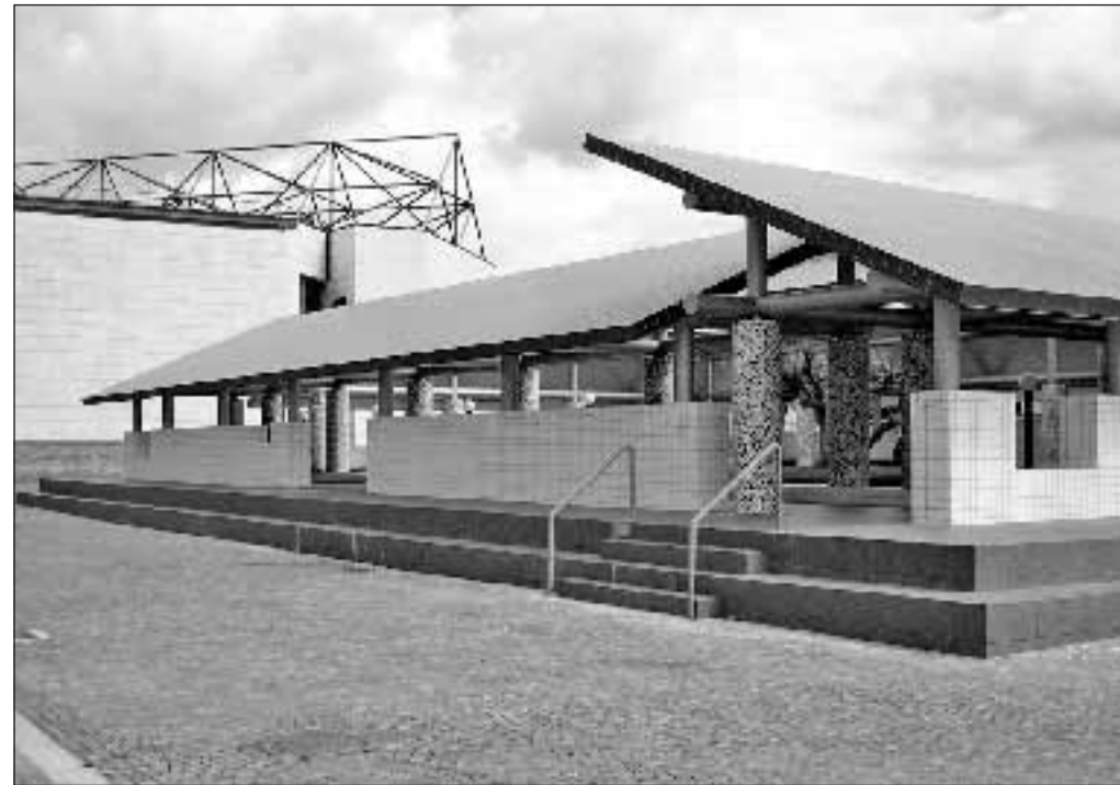
Veduta esterna del «Chiostro della Pace» di Sottsass e Cucchi nel Campus di Fisciano
