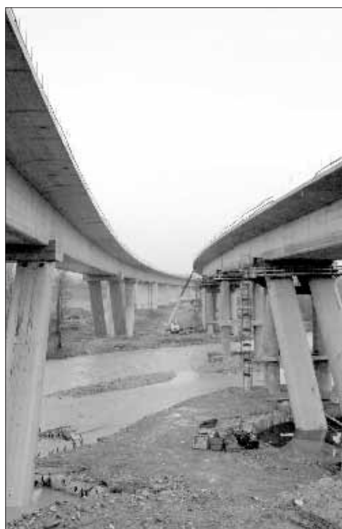
Un viadotto della variante di valico
