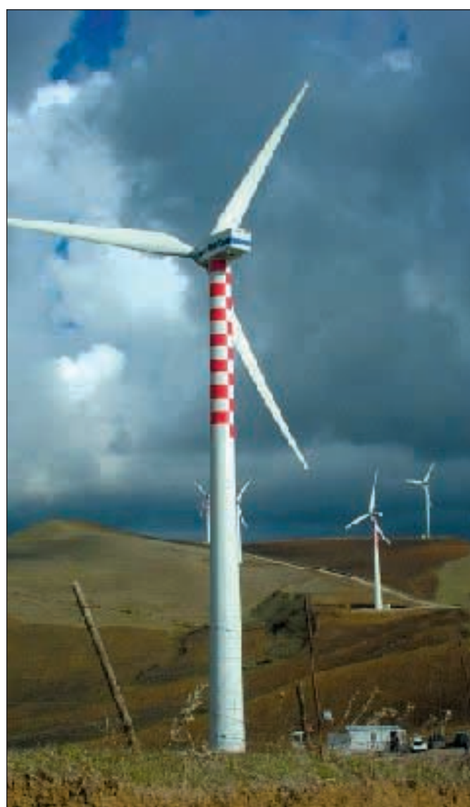
Una centrale eolica
