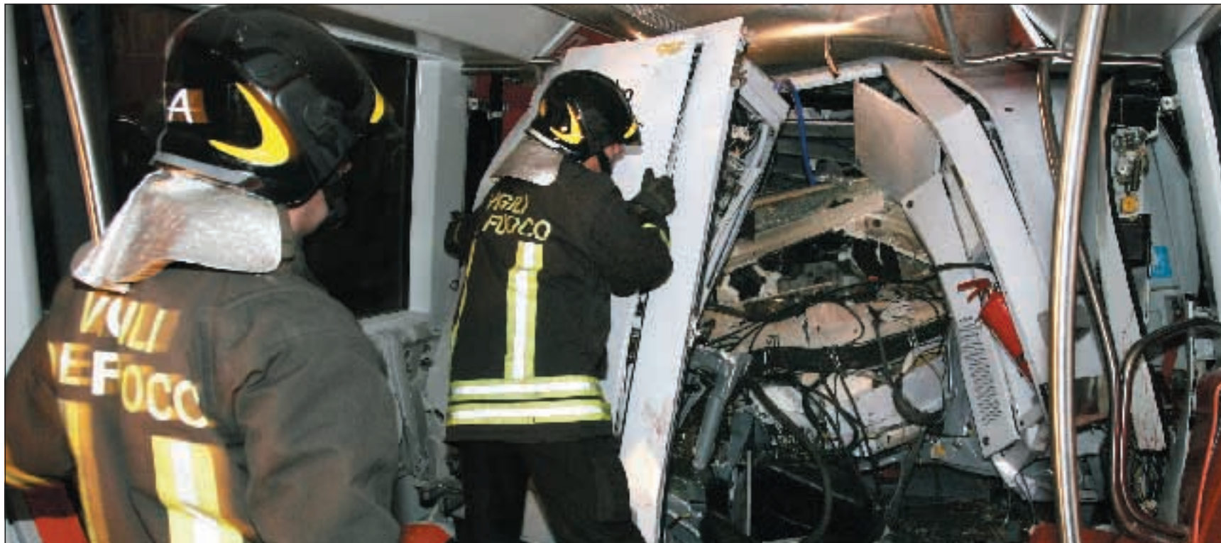
I servizi alle pagine 2, 3 e 4 di Di Blasi, Gerina, Iervasi, Rubenni e Solani Vigili del fuoco rimuovono le lamiere dei convogli della linea A del metrò di Roma. Foto AP Photo/Str
