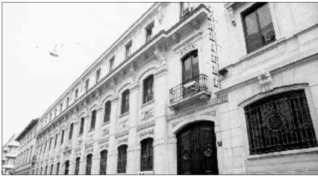
La sede del quotidiano il 'Corriere della sera' in via Solferino a Milano. Foto Ansa
