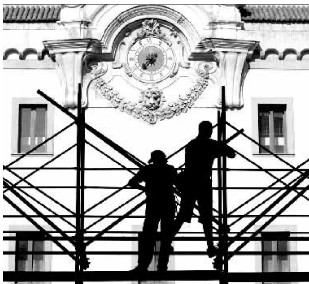
Operai in un cantiere di Napoli in un'immagine d'archivio. Foto di Ciro Fusco/Ansa
