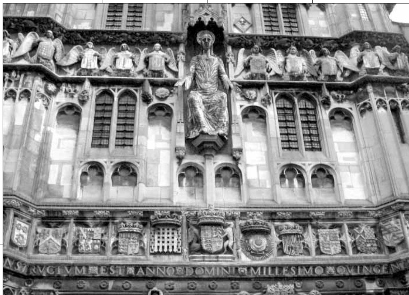
Particolare della facciata della cattedrale di Canterbury
