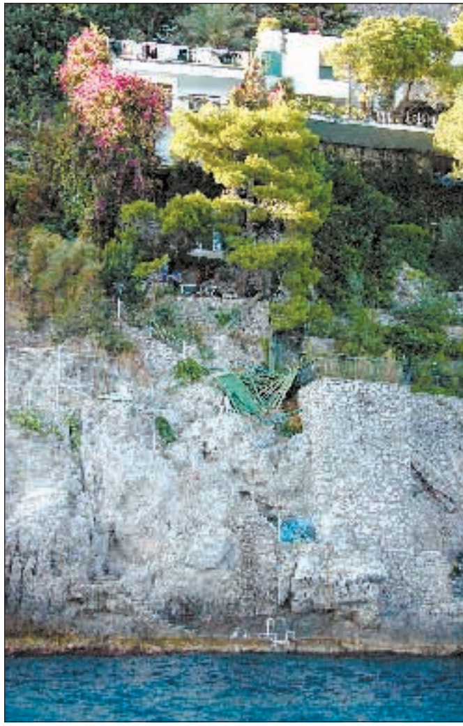
La villa dove è crollata la terrazza in legno a Conca dei Marini Foto Ansa
