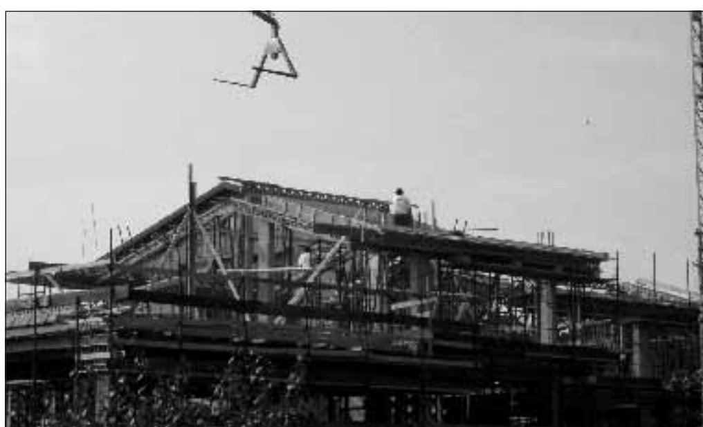
Un cantiere edile
