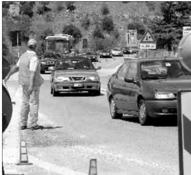
Traffico causato da lavori sull'A3 Salerno-Reggio Calabria Foto Ansa
