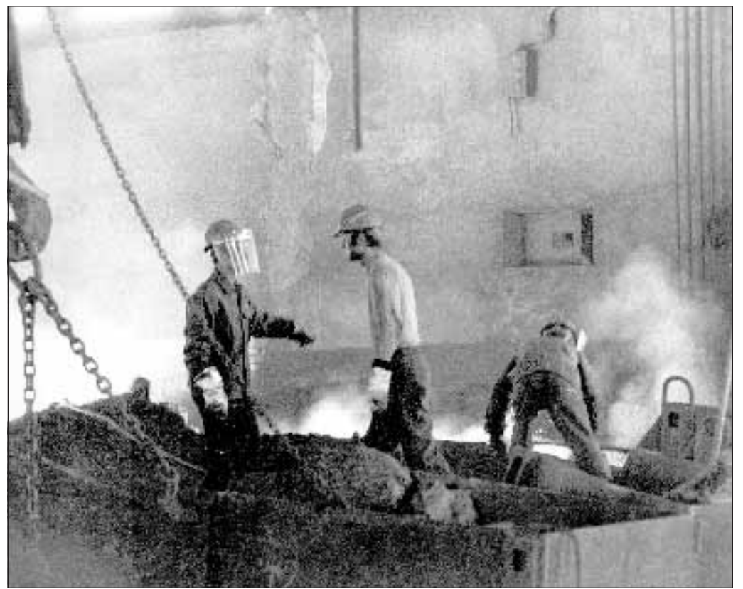
Operai al lavoro negli anni Settanta nell'altiforno dell'Ilva di Taranto. Foto Archivio Unità
