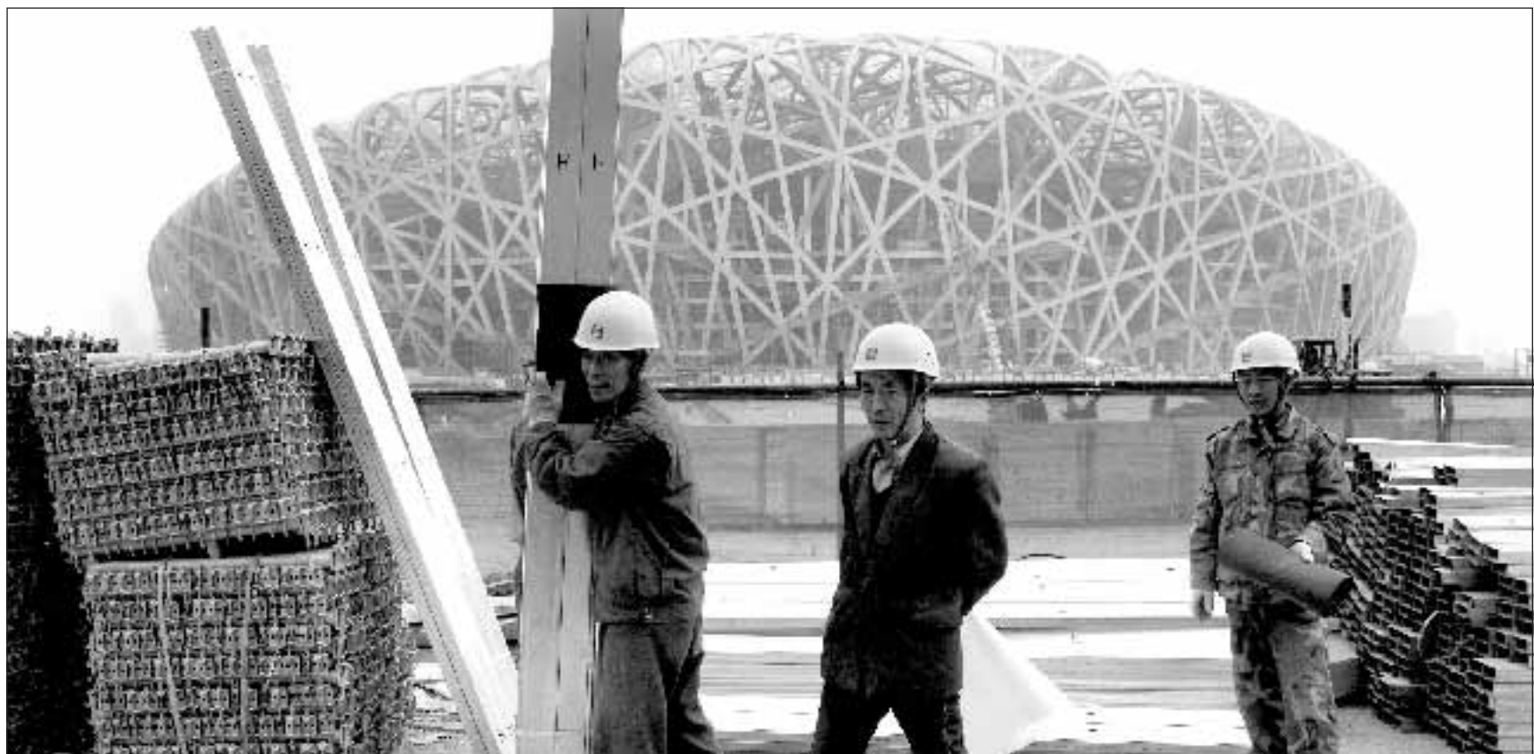
Il nuovo stadio olimpico di Pechino in fase di costruzione. Foto di Andy Wong/Agf
