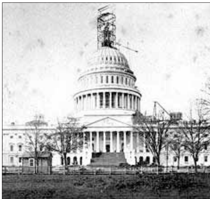
Capitol Hill in costruzione
