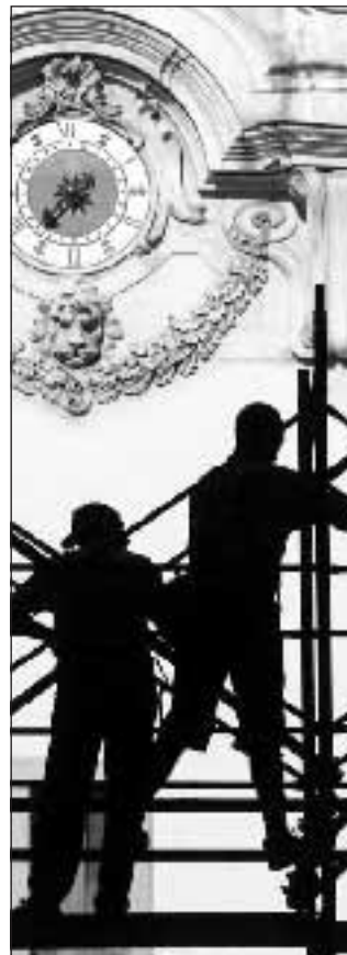
Un cantiere edile Foto Ansa
