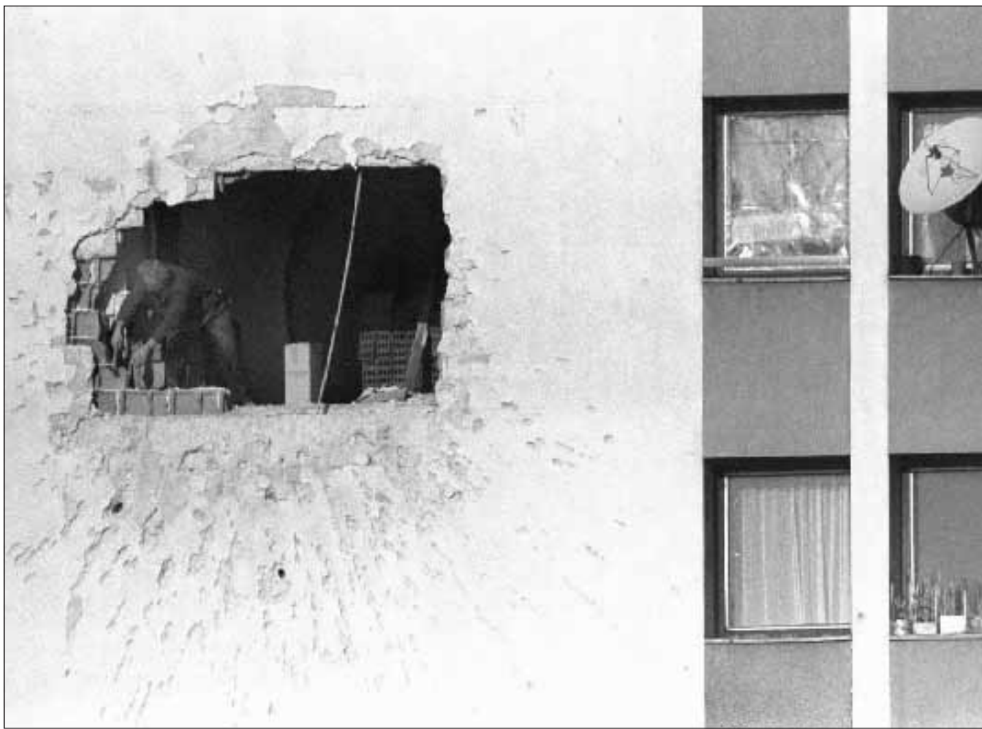
Sarajevo, un palazzo colpito dai bombardamenti
