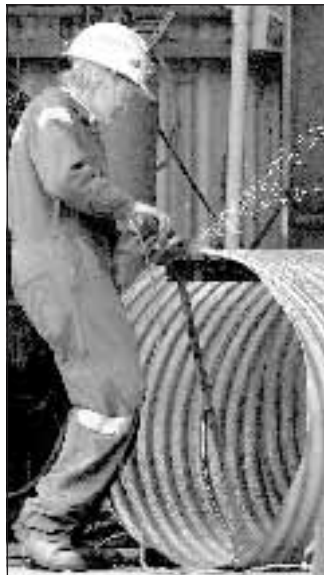
Un operaio al lavoro. Foto Ansa
