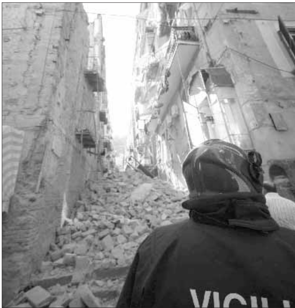
Il palazzo crollato ai quartieri spagnoli, a Napoli. Foto di Cesare Abbate/Ansa
