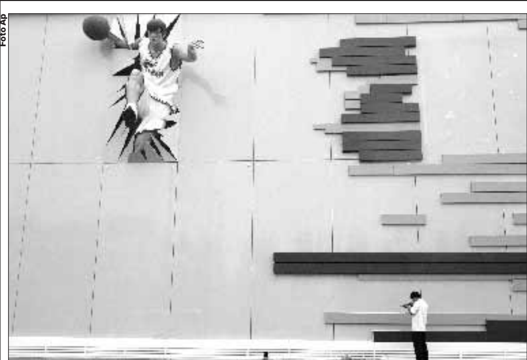
GINA Ultimi preparativi per le Olimpiadi SONO GLI ULTIMI GIORNI prima del via. A Pechino si stanno concludendo i lavori di costruzione degli impianti che ospiteranno le tantissime Olimpiadi. Impianti moderni, come questo ritratto dalla foto che farà da cornice alle partite di pallacanestro.
