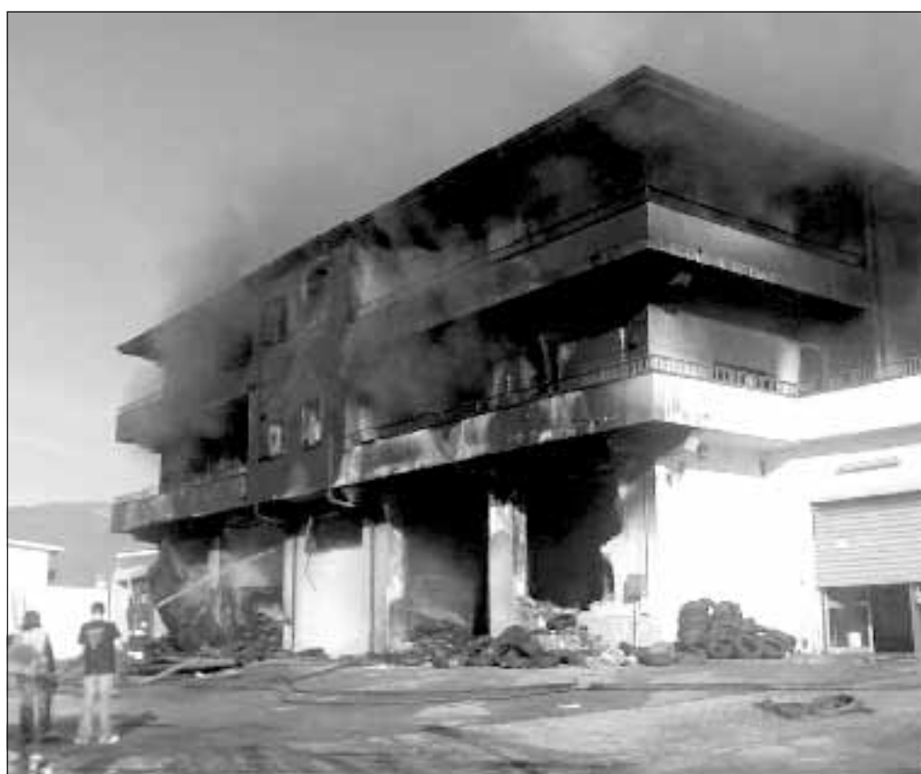
Il deposito di gomme incendiato a Lamezia Terme. Foto Ansa
