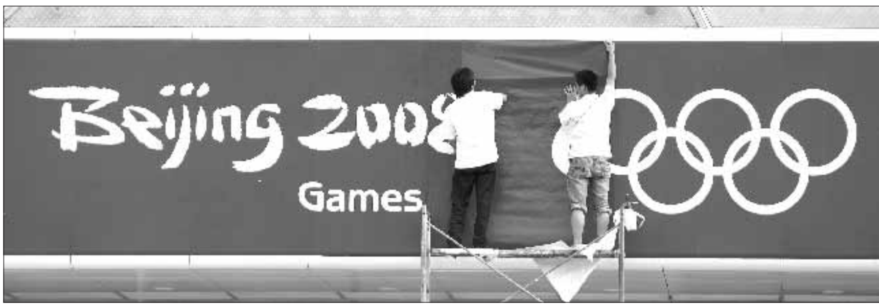
I lavori di smontaggio delle scritte olimpiche Foto di Greg Baker/Ap
