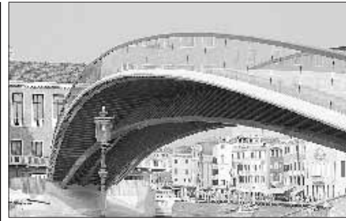
Il ponte di Calatrava
