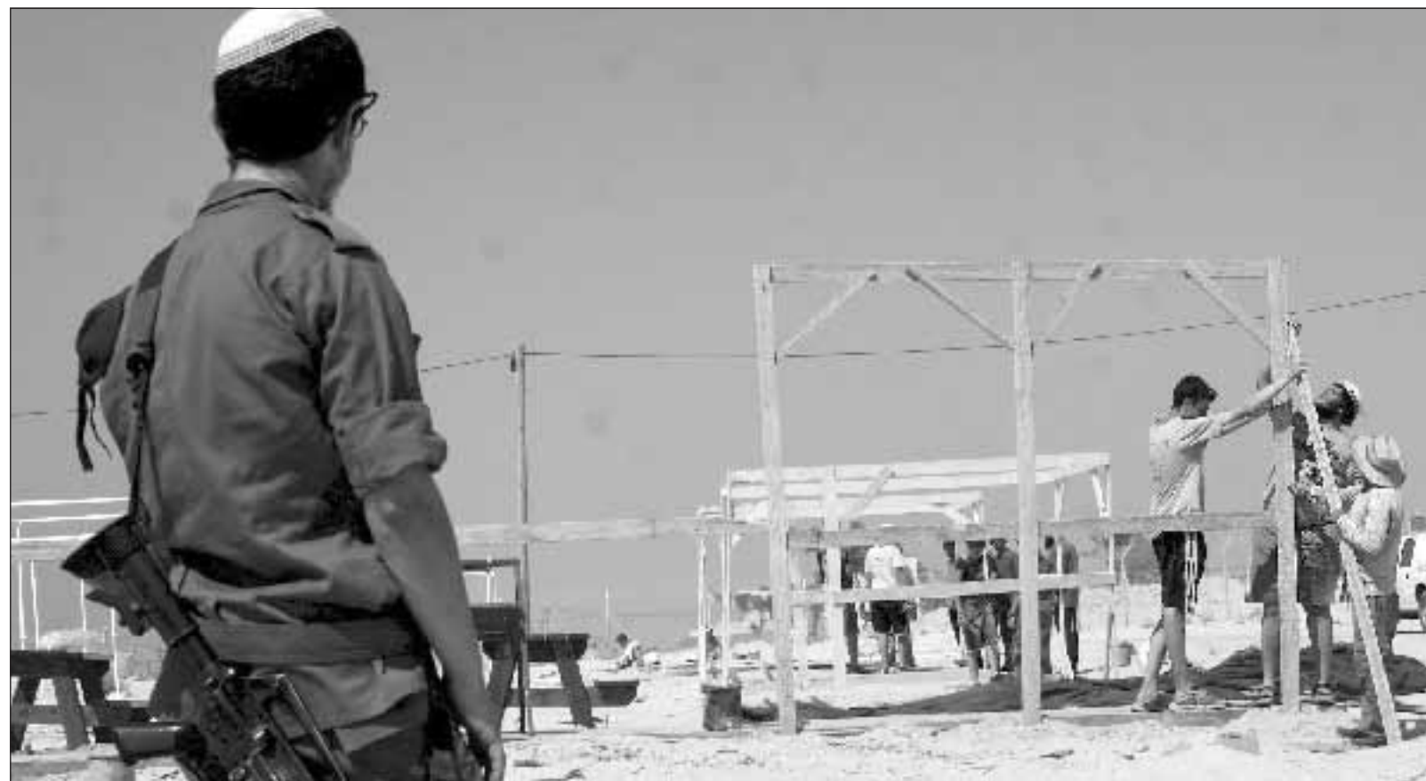
Un soldato israeliano controlla i lavori di alcuni coloni. Foto di Orel Cohen/Ansa-Epa
