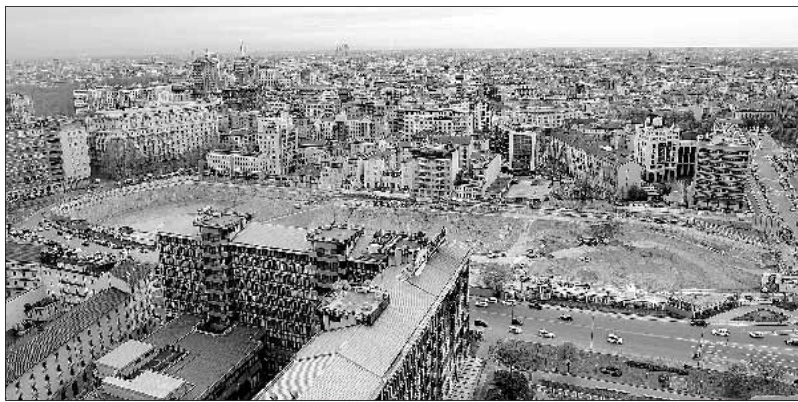
Una panoramica del cantiere dell'Expo nell'area delle Varesine a Milano. Foto di Daniel Dal Zennaro/Ansa
