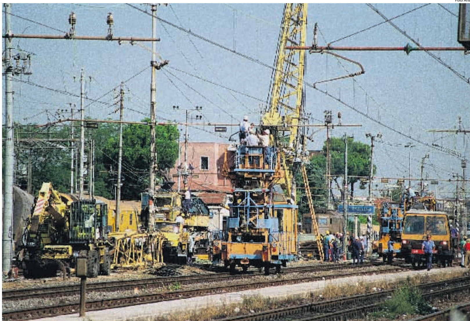
Lavori sulla linea ferroviaria Roma Formia
