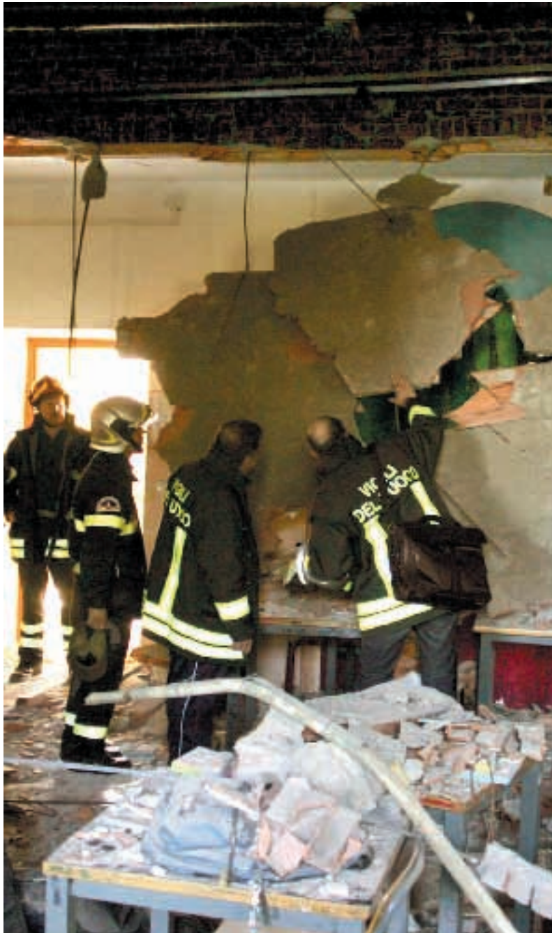
Vigili del fuoco ispezionano l'aula del liceo Darwin dopo il crollo
