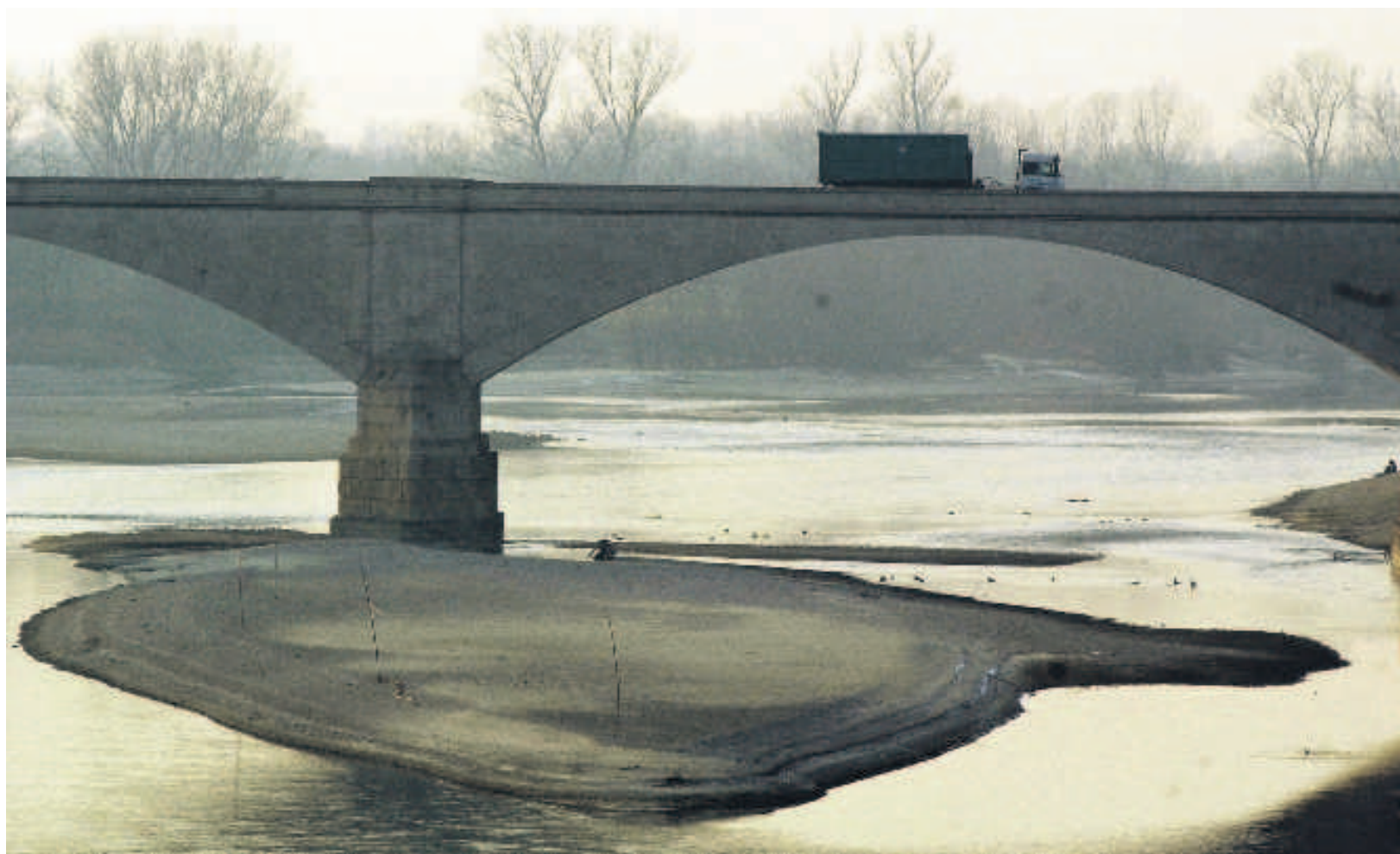
Voghera-Milano Il ponte sul Po, a Pavia
