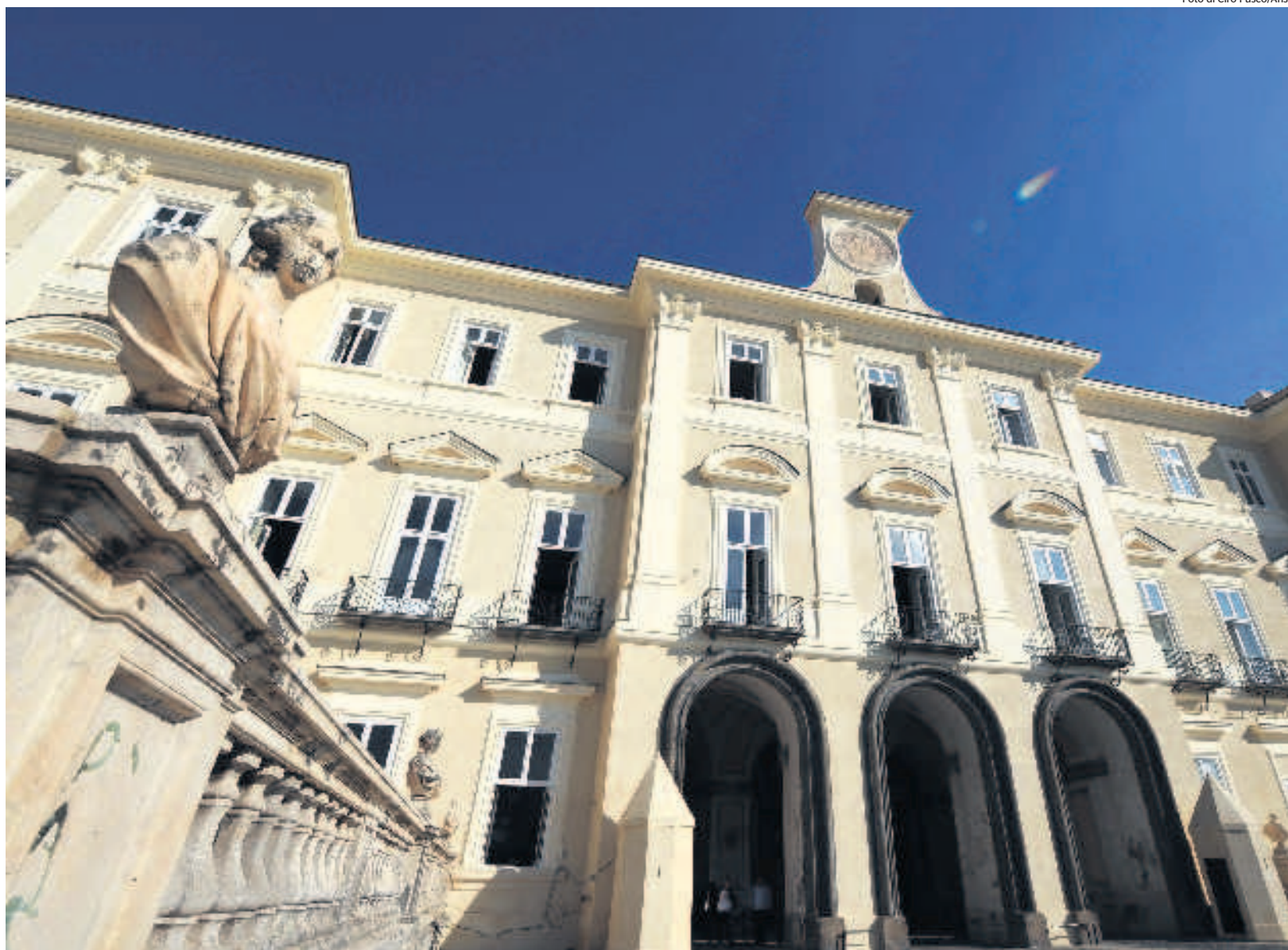
La Reggia borbonica di Portici, Napoli. La facciata meridionale è stata restaurata con un intervento finanziato da Provincia e Regione Campania
