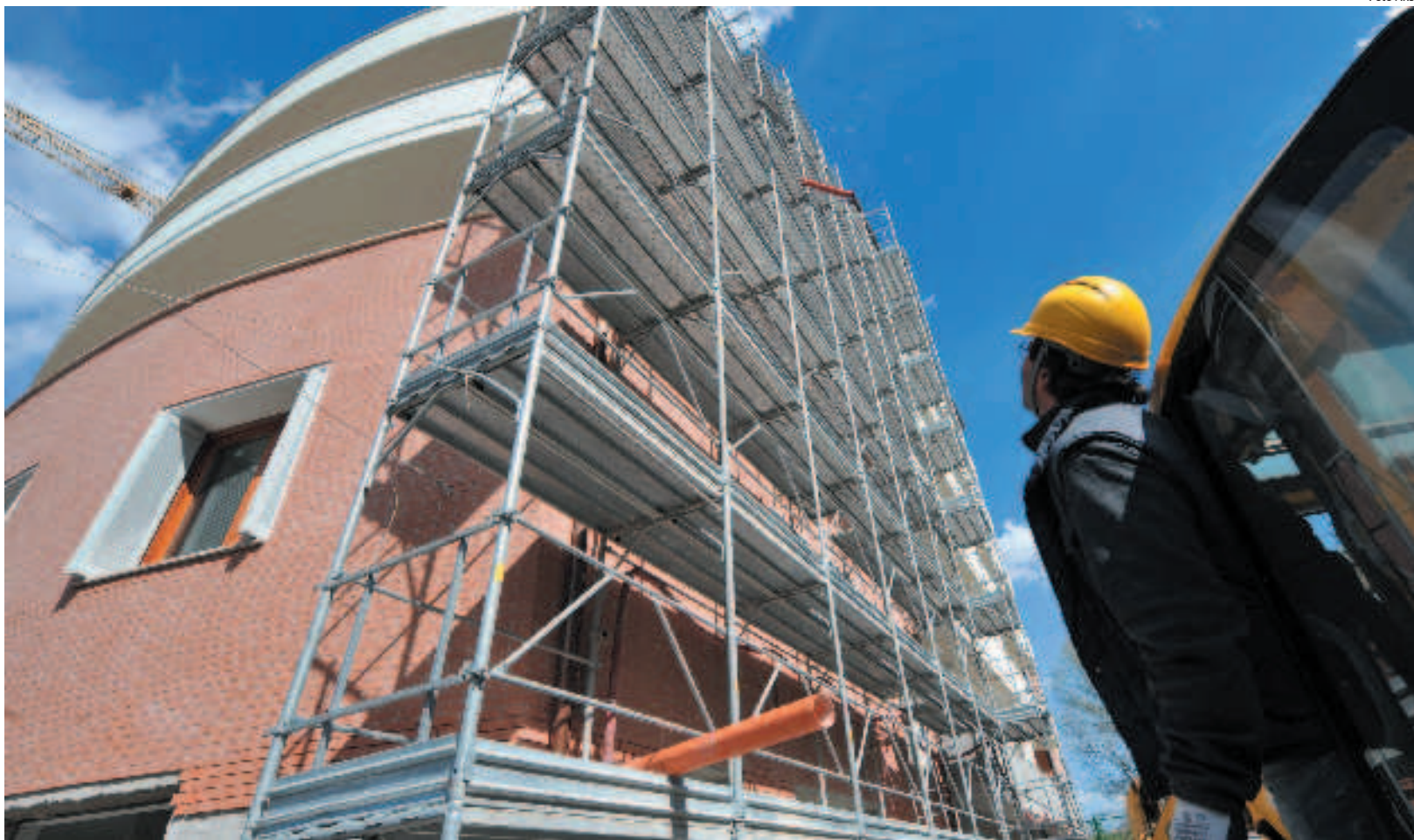
Un cantiere edile a Pontedera (Pisa)
