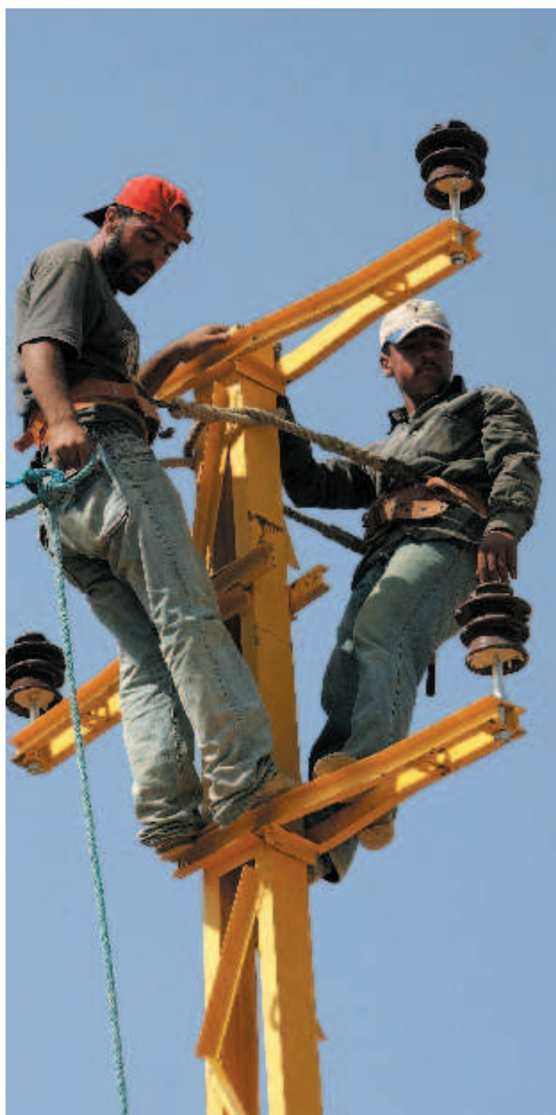
Operai in condizioni rischiose di lavoro riparano fili dell'alta tensione
