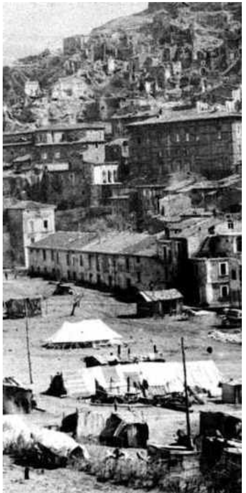
Pescina (Avezzano) distrutta dopo il terremoto del gennaio del 1915
