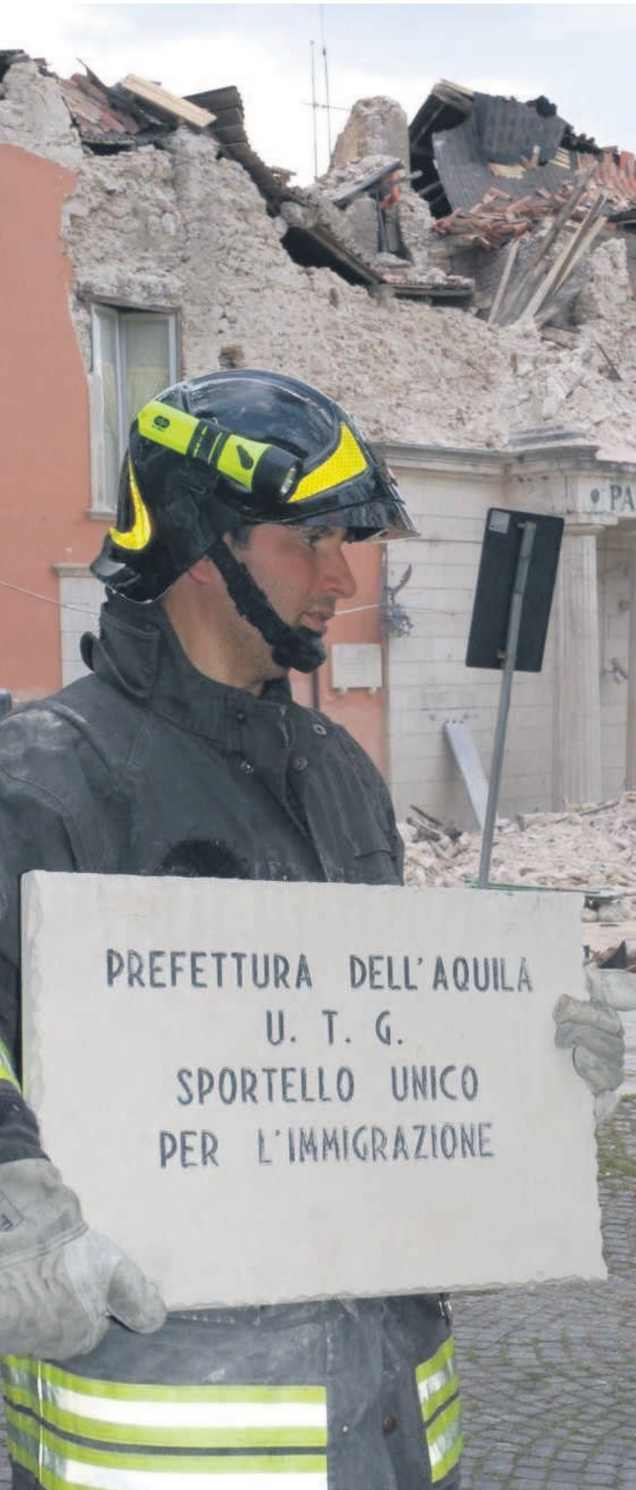
Vigili del fuoco rimuovono le targhe all'esterno del palazzo crollato della Prefettura de L'Aquila
