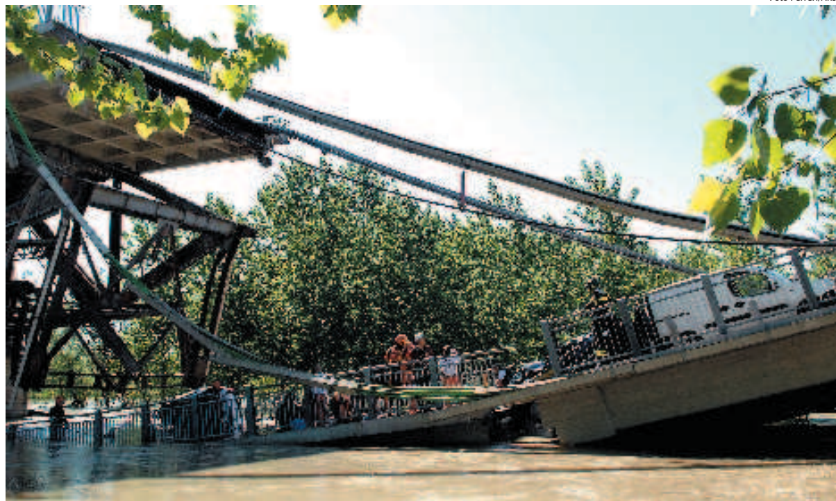
Il cedimento di un pilone di un ponte sul Po, tra Lodi e Piacenza
