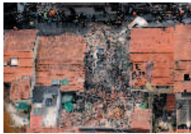
I danni provocati dall'esplosione
