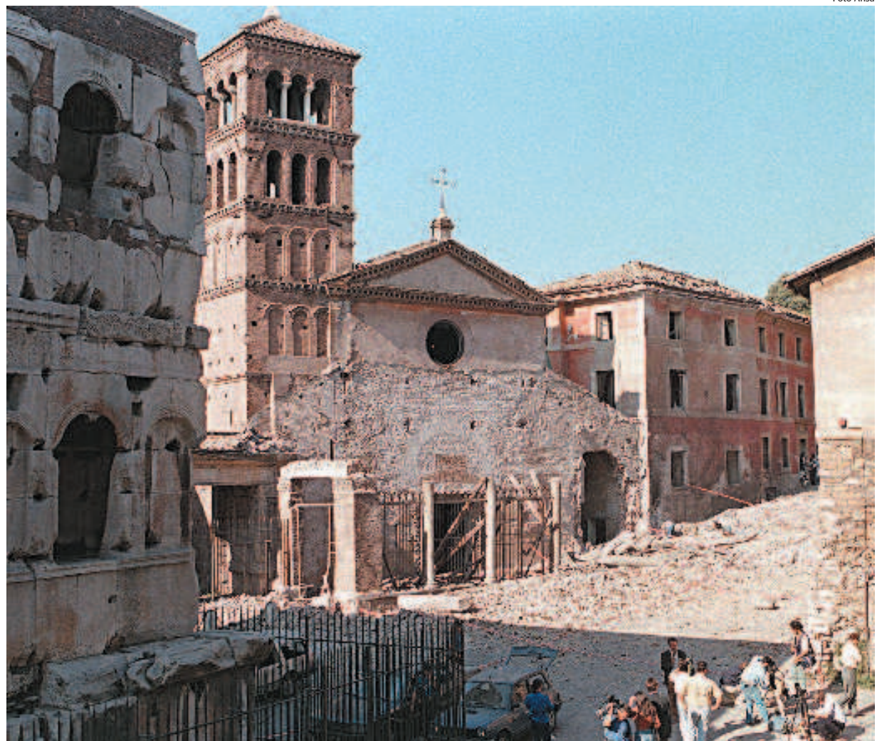
La chiesa di San Giorgio al Velabro a Roma dopo l'attentato compiuto poco dopo la mezzanotte tra il 27 e il 28 Luglio 1993
